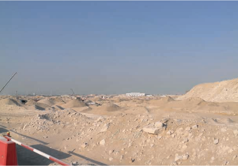
Baustellenzufahrt zum künftigen Expo-Areal
