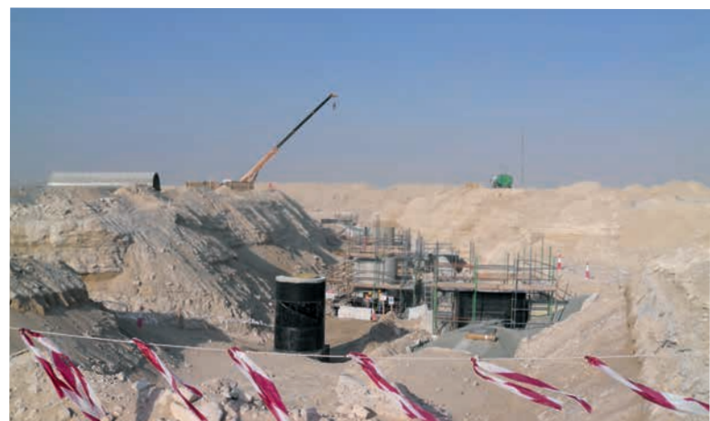
Bei den Erschließungsarbeiten wird für die Nachnutzung mitgebaut.
